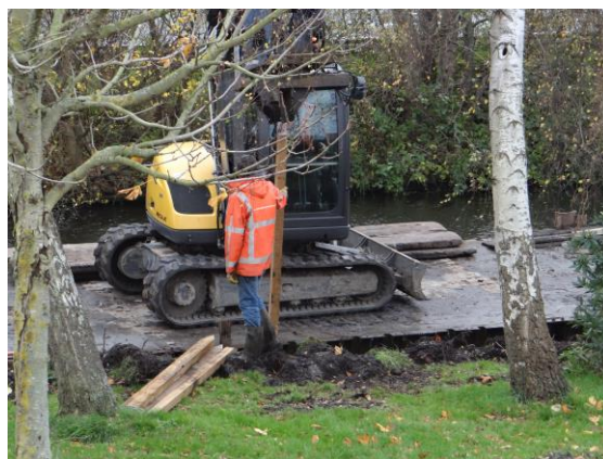
Vanaf een ponton worden palen in de oeverwand gedrukt
